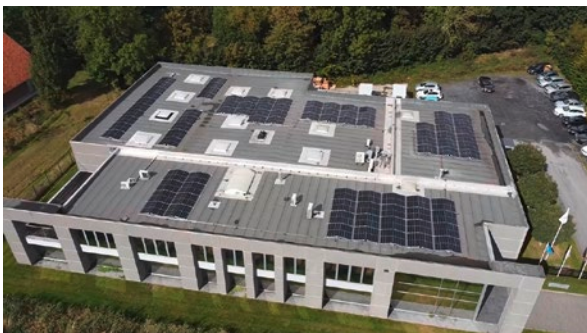
Εγκατάσταση ολοκλήρωσης συστημάτων της Hach στη Ναζαρέτ, Βέλγιο
